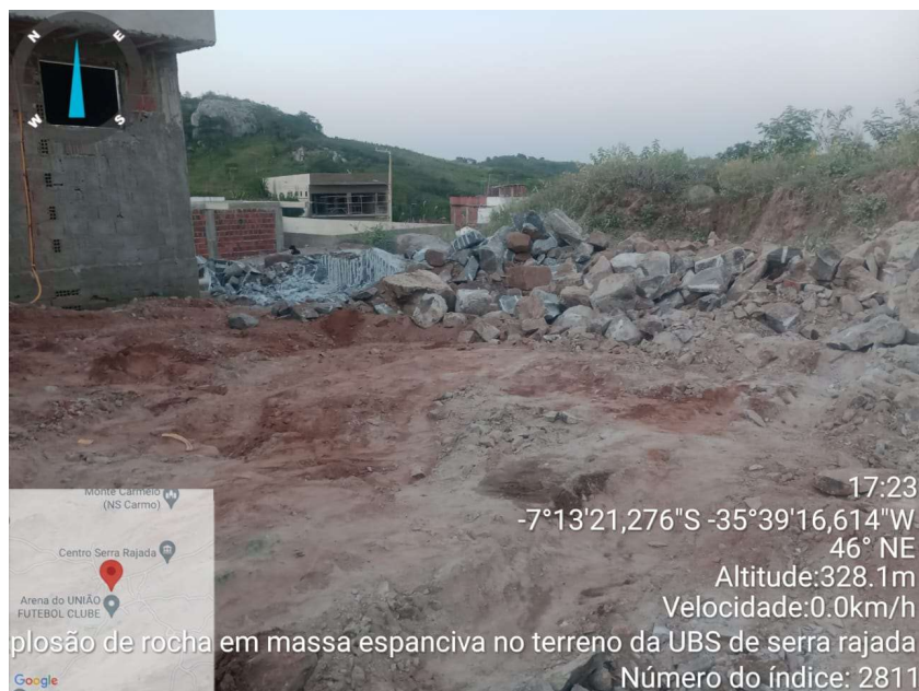
Figura 1: Pedras que serão desmontadas
